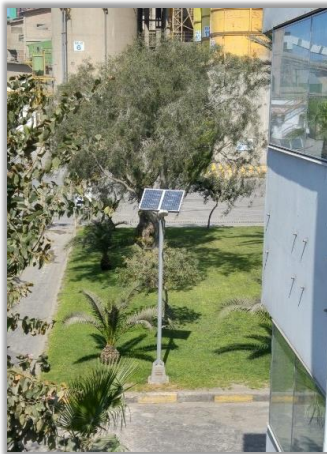
Πυλώνες Οδικού Φωτισμού
