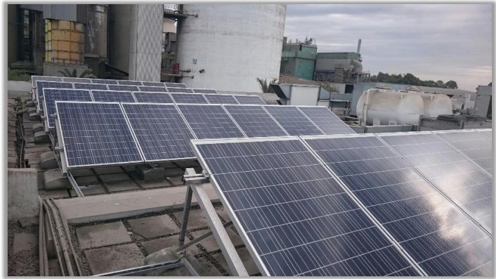
Εγκατάσταση Φωτοβολταϊκών 20 kWp στις οροφές κτιρίων της TB
