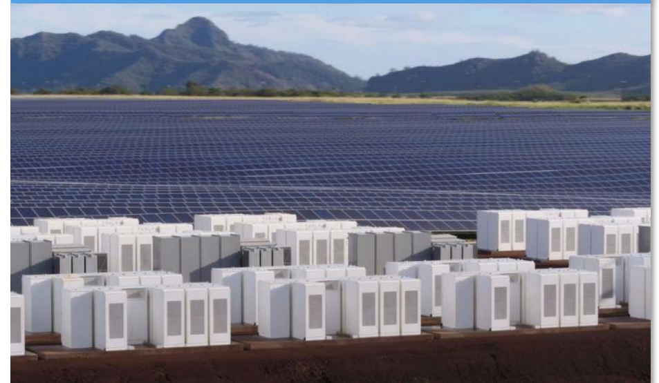
52MWh Μπαταρία Αποθήκευσης – 13MW Φωτοβολταϊκό Πάρκο στο νησί Kauai στη Hawaii
