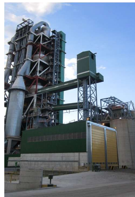
Σύστημα τροφοδοσίας εναλλακτικών Πρώτων Υλών και Εναλλακτικών Καυσίμων T.B
